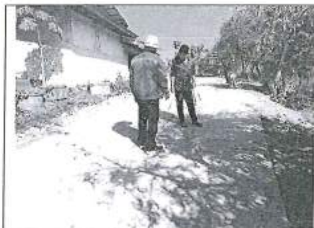
ก่อสร้างถนน
