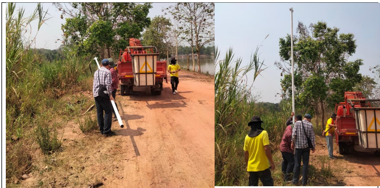
ติดตั้งไฟฟ้า
