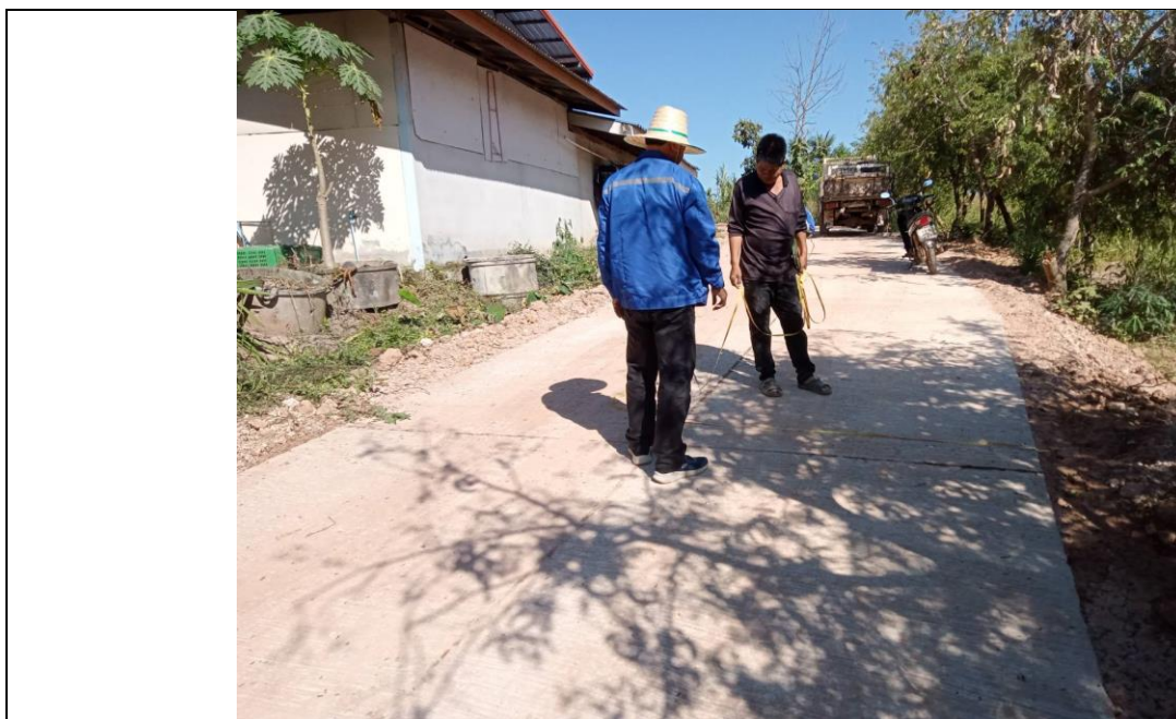
ก่อสร้างถนน
